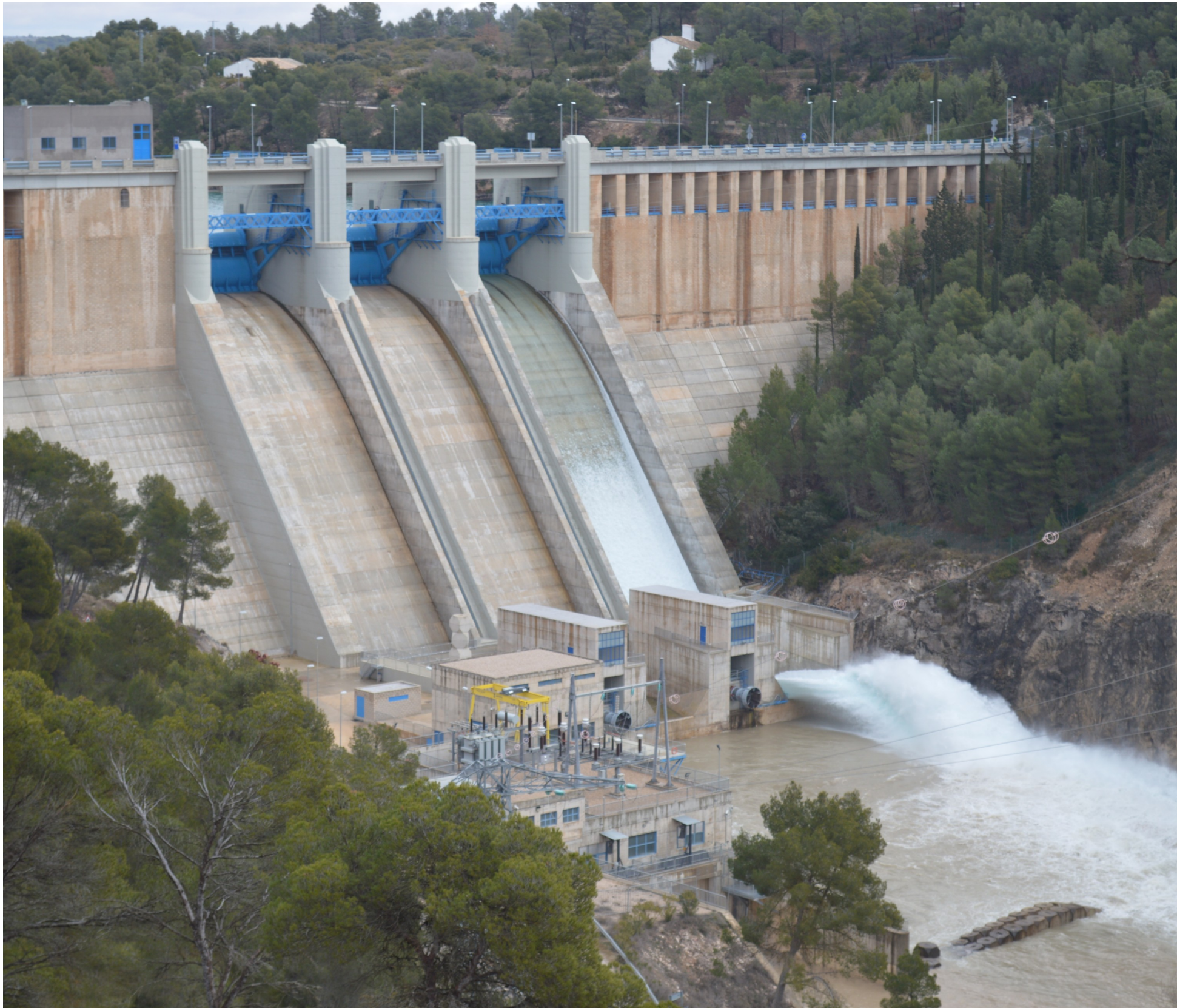
Foto: Presa de Alarcón en el río Júcar
